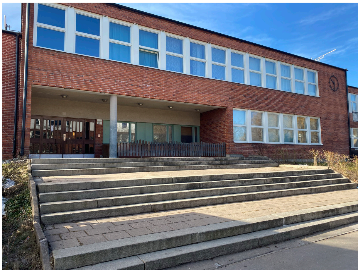
FÖRE DETTA STORHOLMSSKOLAN RITADES AV YNGVE ALVÅ 1976 OCH BYGGDES OM TILL BOSTÄDER 1997.
