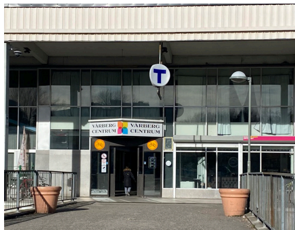
VÅRBERGS CENTRUM OCH TUNNELBANESTATION
