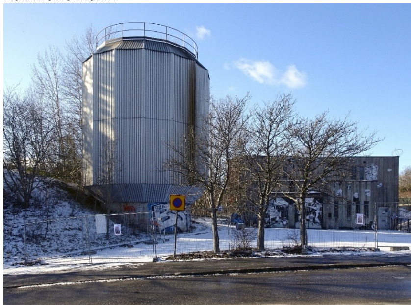
Befintlig byggnad och oljetank inom fastigheten Kummelholmen 2.
