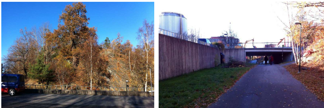
Vänster; parkeringsyta och berghäll norr om fastigheten. Höger; Gång- och cykeltunnel sedd från norra sidan av fastigheten Aspholmen. Oljetanken inom fastigheten Kummelholmen 2 syn i bilden.
