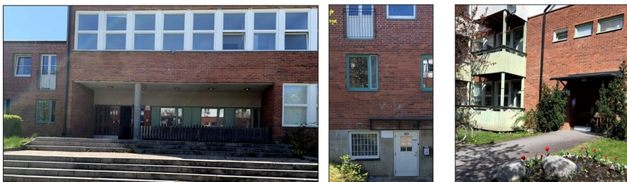
Detaljer på befintliga byggnader (gamla skolbyggnader:) Byggnaderna har fasader av rött tegel i löpförband och sammanhängande stora fönsterpartier. Merparten fönster är vitmålade, men det finns också en mindre del fönster som är grågröna. Möjligen är den grågröna färgen ursprunglig.
