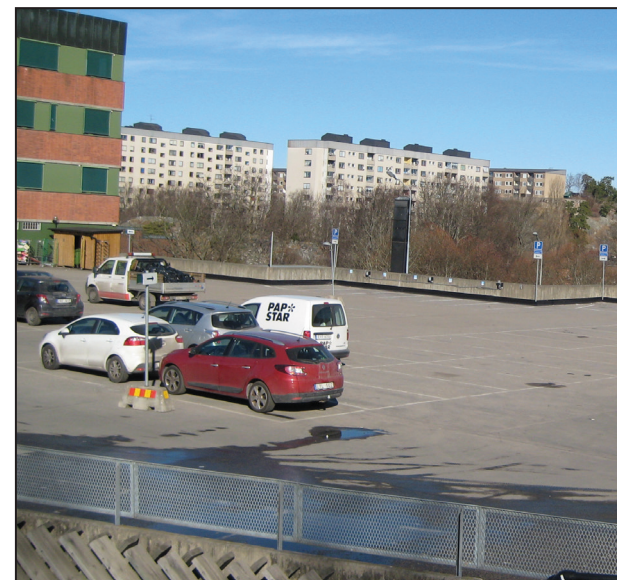
Parkeringsanläggning i Bredäng.
