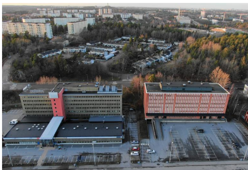
Flygfoto år 2020 över närmast liggande industrifastigheter samt Larsboda radhusområde på andra sidan Mårbackagatan. Vy mot väst.
