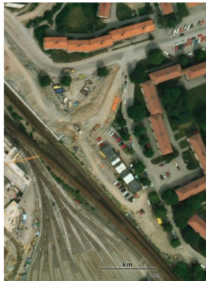
Ortofoto från 2006, omdragning av Ångermannagatan påbörjad samt upplag och uppställning av baracker vid träden. Lindarna befann sig i en byggarbetsplats.
