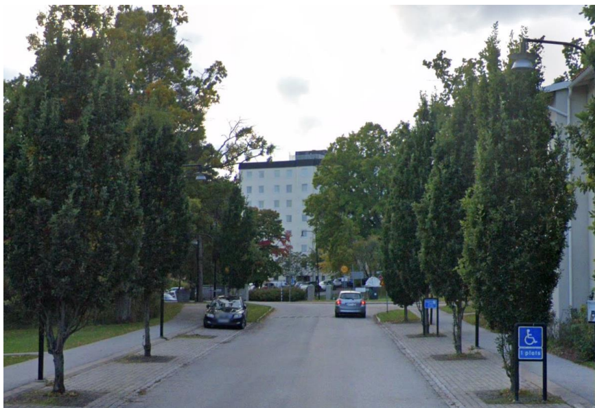
Figur 17. Befintlig utformning av Nils Lövgrens väg (från Google streetview) - dagvatten från vägytan når inte trädplanteringen.
