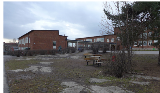
Vy mot huvudbyggnadens sydöstra långsida samt de sammanbyggda mindre volymerna som inhyser Midsommarkransens grundskola.
