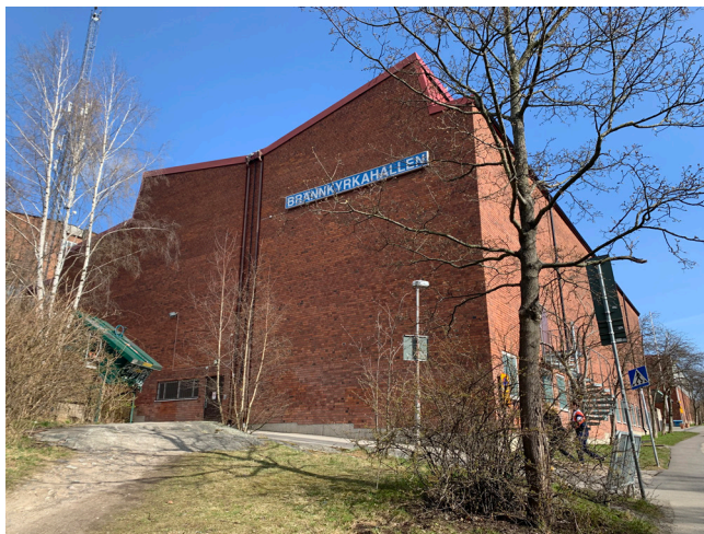
Brännkyrkahallens motfallstak skapar ett karaktärsskapande gavelmotiv mot väst.
