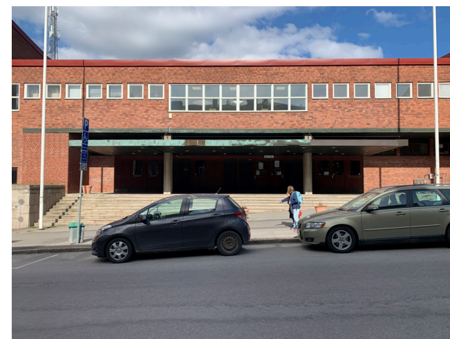
Mittpartiet med entréparti mot gatan.
