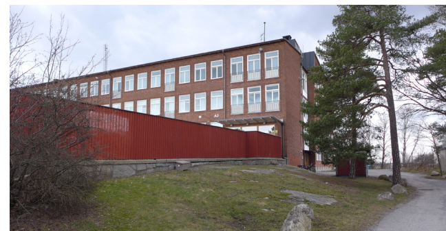
Ett högt staket avskiljer skolgården från vägen i fastighetens norra del. Observera ursprunglig granitmur under staketet.
