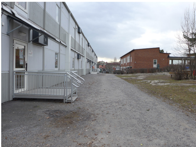
Barackbyggnadens nordöstra fasad.
