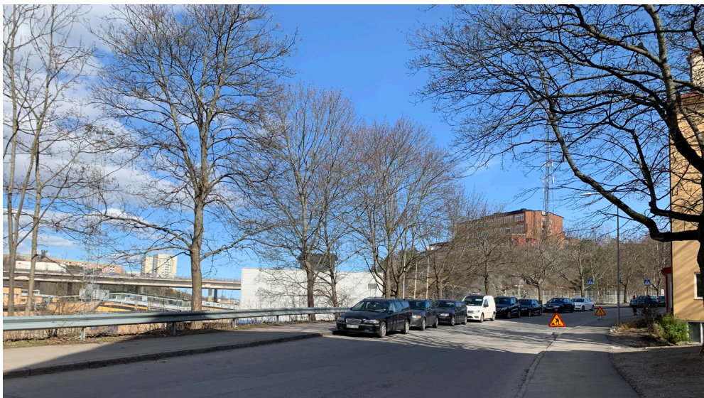
Delar av skolanläggningen sedd från Tellusborgsvägen i väst. Observera trädraden längs vägen.
