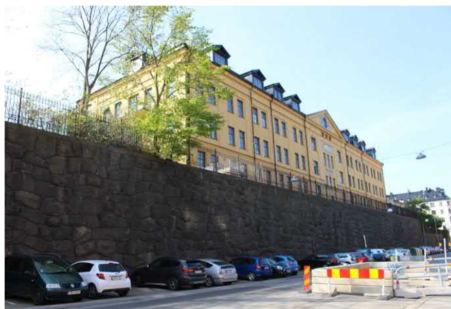
Muren mot Heleneborgsgatan.
