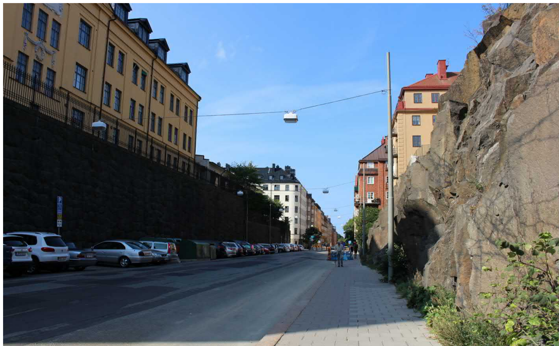
Heleneborgsgatan västerut i höjd med Borgerskapets Gubbhus som syns på vänster sida. Bergskärningen till höger i bild är särskilt betydelsefull för möjligheterna att förstå områdets topografi och hur man strävat efter att bemästra den.
