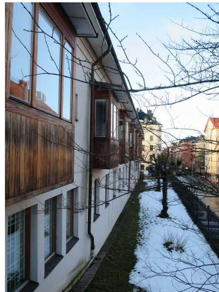
Lågdelen/länkbyggnadens norrsida mot Heleneborgsgatan har i den västra delen av bottenvåningen bevarad fönstersättning från 1960-talet.
