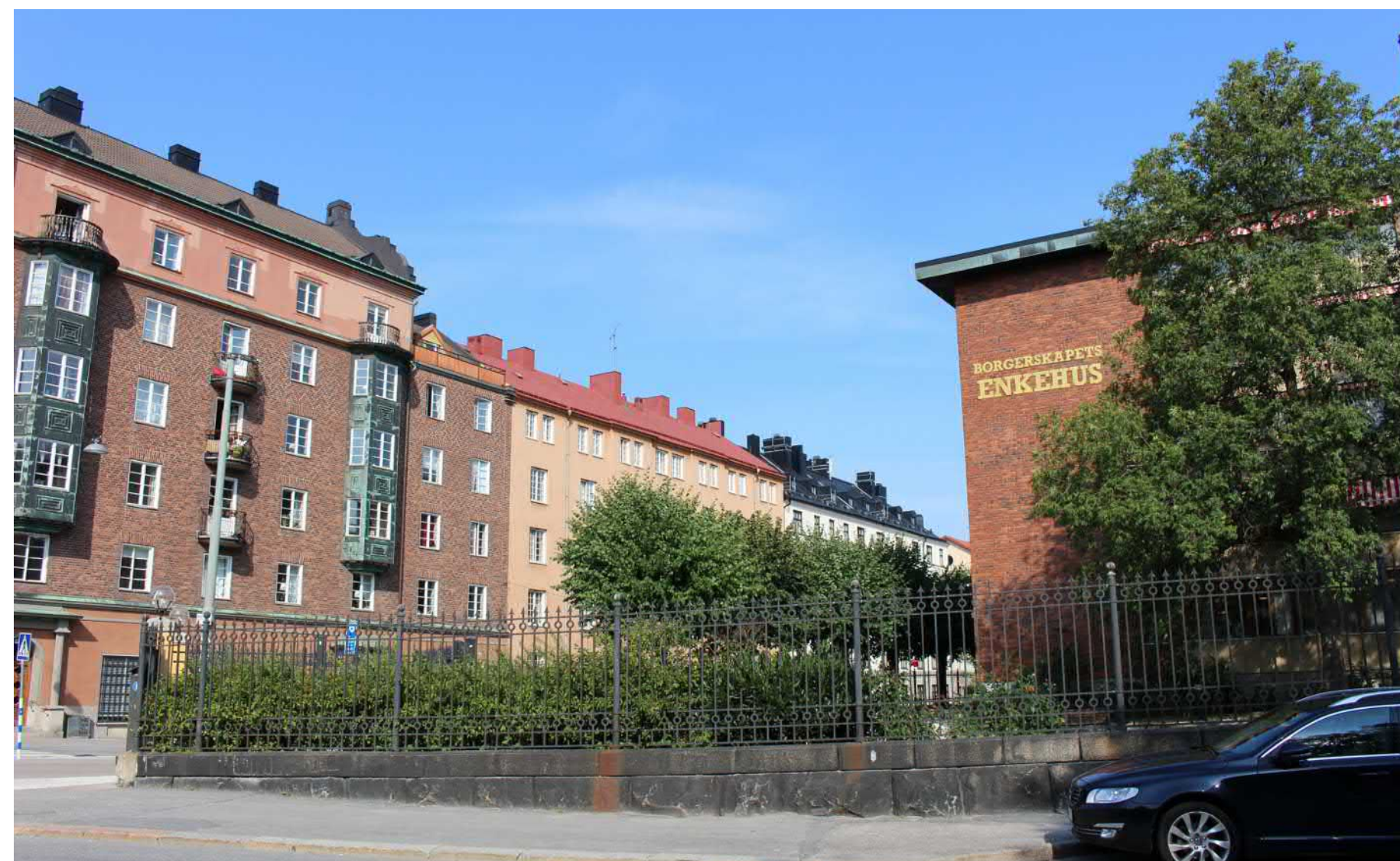
Stenstadshus längs med Varvsgatan uppförda under 1900-talets inledade årtionden. Till vänster kvarteret Yxan.
