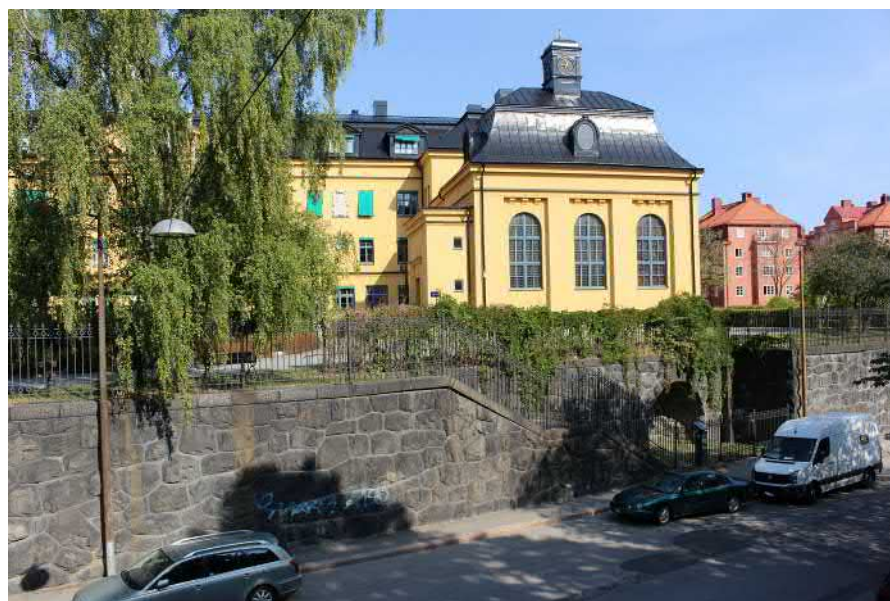
Muren mot Högalidsgatan med idag avstängd ingång.
