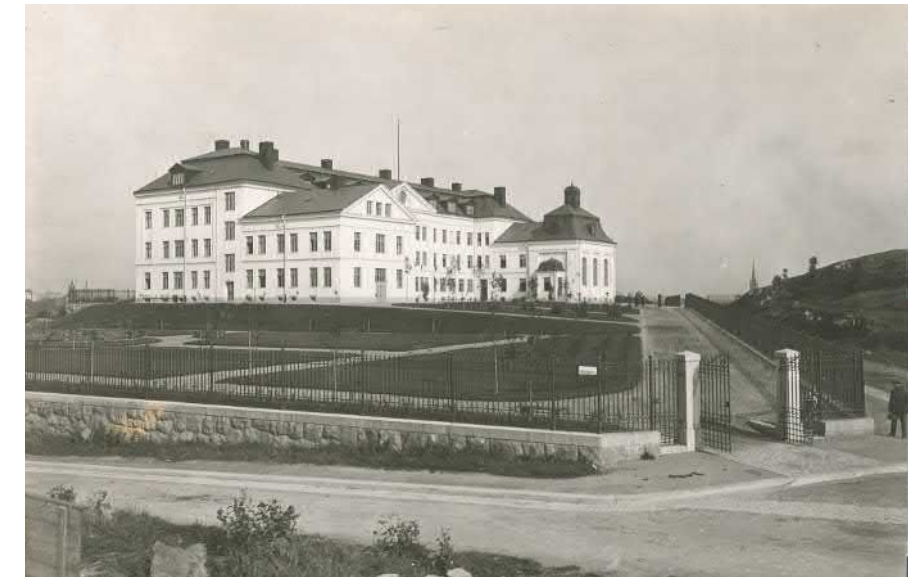
Fotografi från 1910. Hörnet Varvsgatan-Högalidsgatan med entré och uppfart till Borgarhemmet och gården. Öppningen är idag breddad och har en ny indragen grindlösning.
