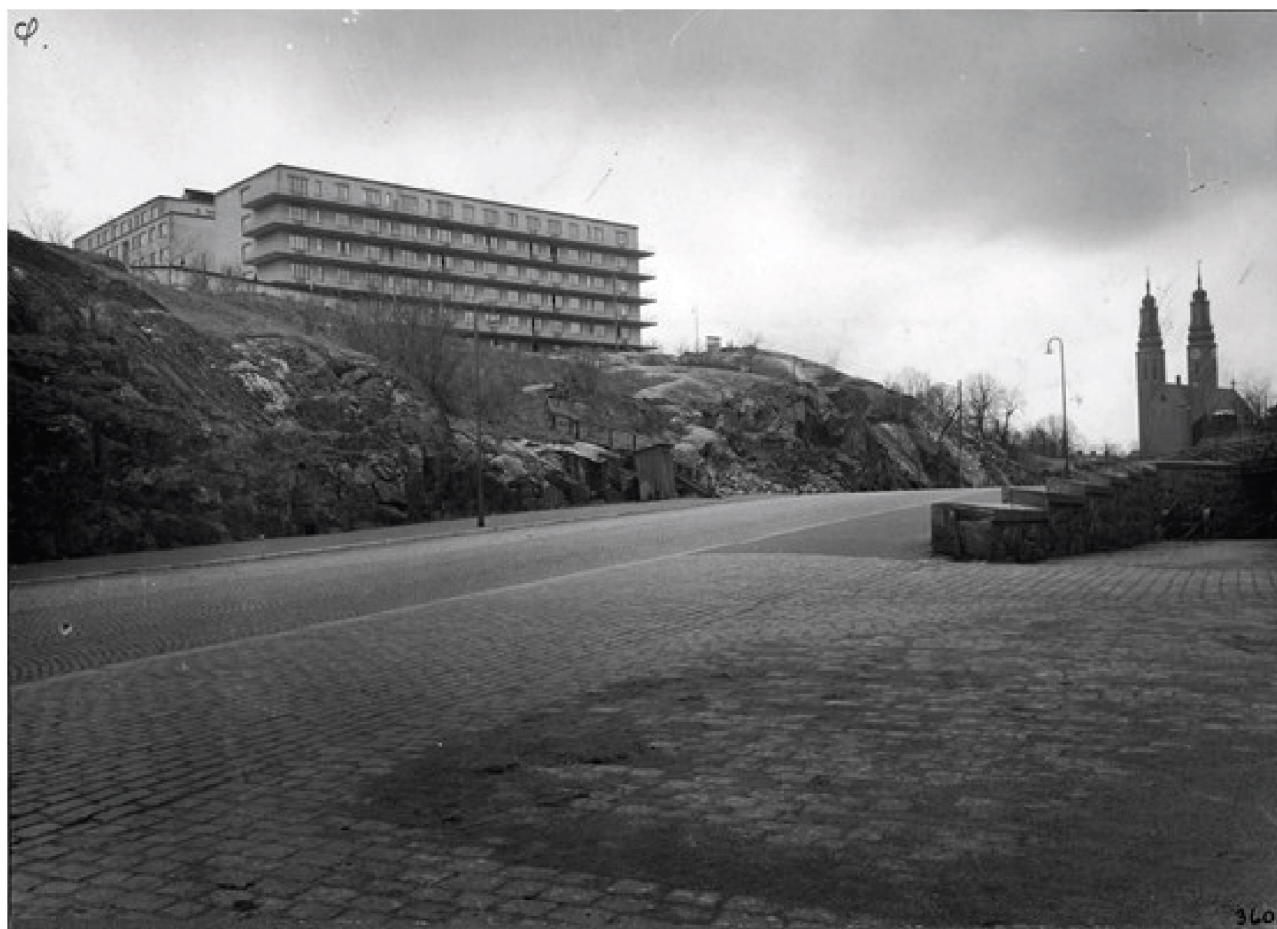
Högalidsgatan från nordost år 1930. Bebyggelsen i kvarteret Marmorn på berget håller på att färdigställas. Den naturliga bergsformationen som präglar gaturummet framträder särskilt på denna bild. Foto hämtat i HSB:s arkiv.
