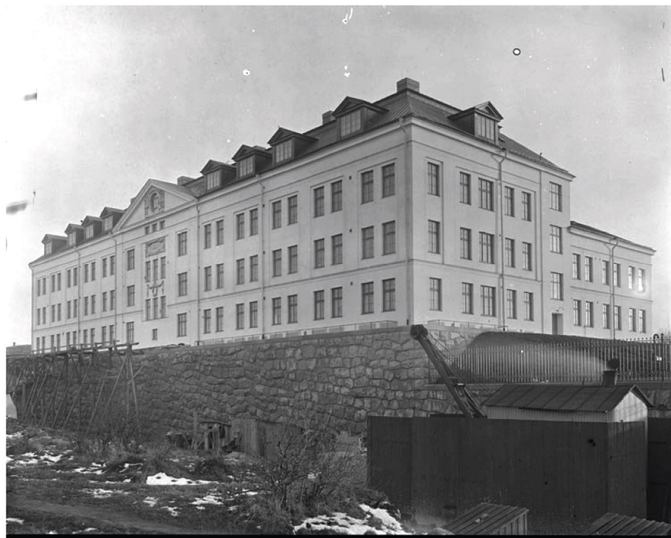
Gubbbhuset 1904-08 under byggtiden. Fotot är taget från dagens Heleneborgsgatan som ännu inte anlagts. Källa: Stockholmskällan.
