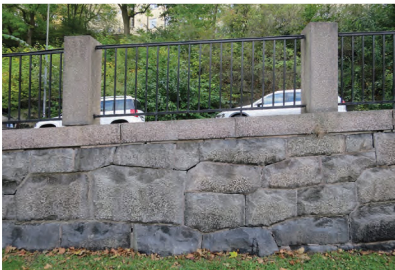
Den murade rampen vid Kristinehovsgatan är av typen polygonmur i huggen granit liksom Borgarhemmets mur på motsatt sida Högalidsgatan men är inte utförd med samma precision.
