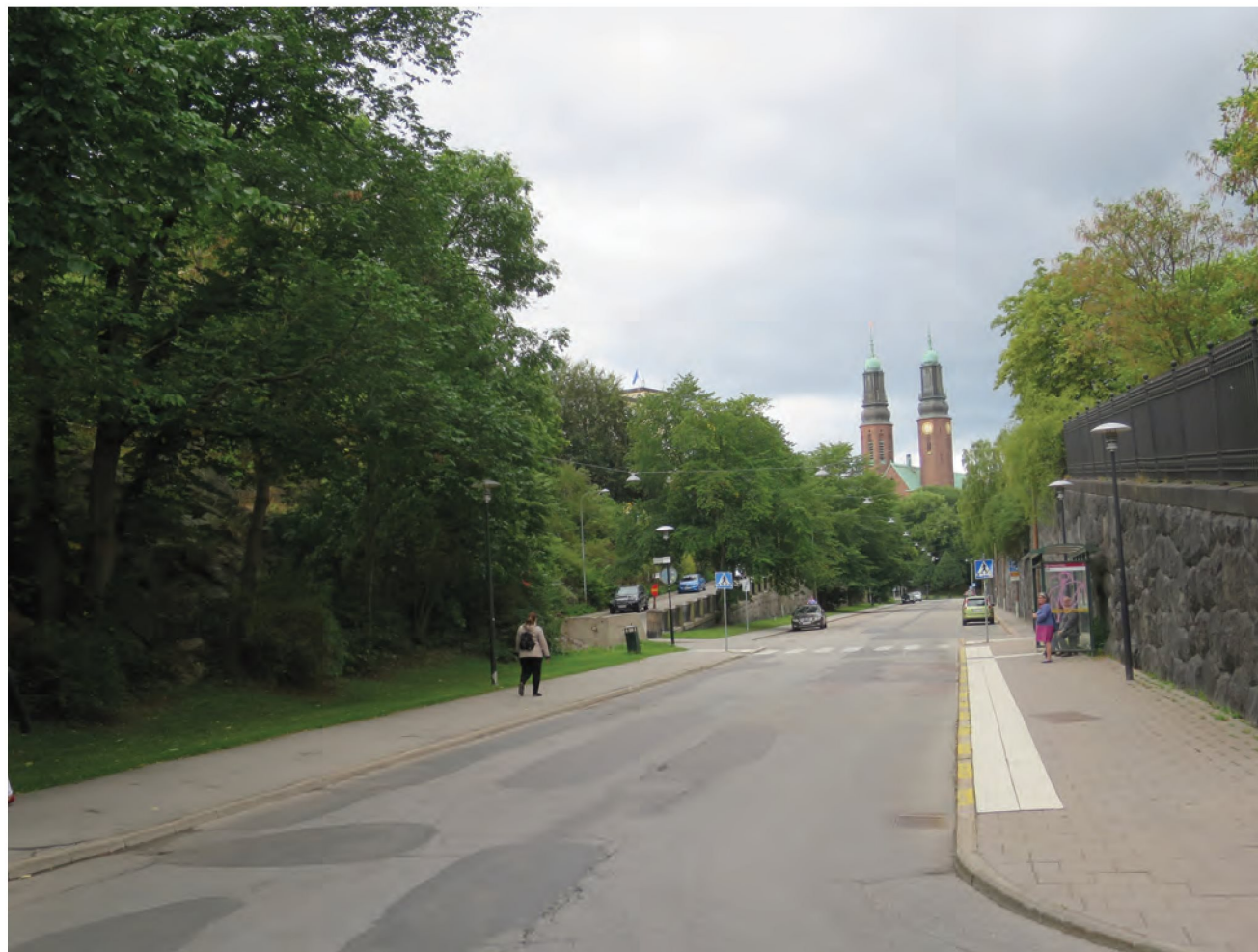
Högalidsgatan mot väster. Höga naturstensmurar med staket finns på var sida om gatan och skapar ett gaturum med delvis sluten karaktär trots det breda gaturummet och den sparsamt förekommande bebyggelsen.
