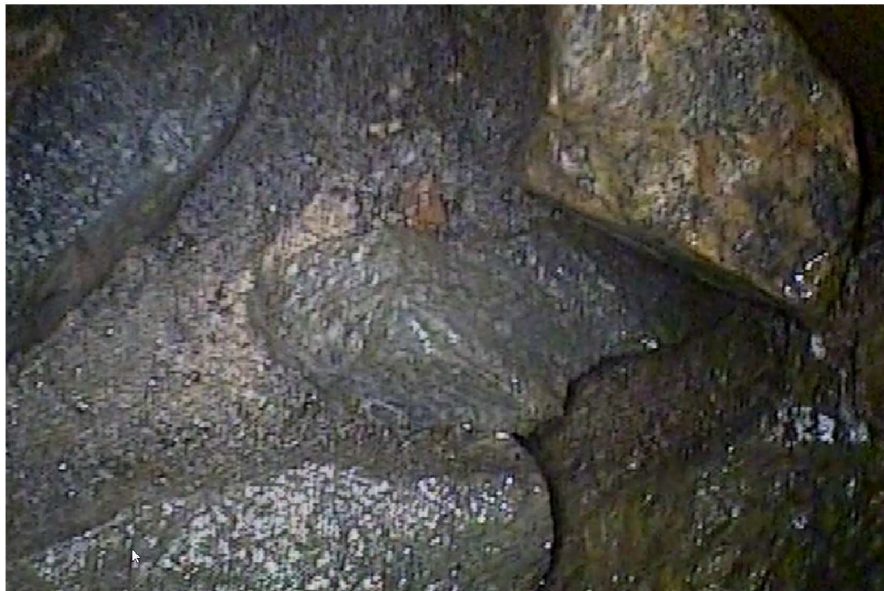
Bild 17. Foto från murinspektion med inspektionskamera.
