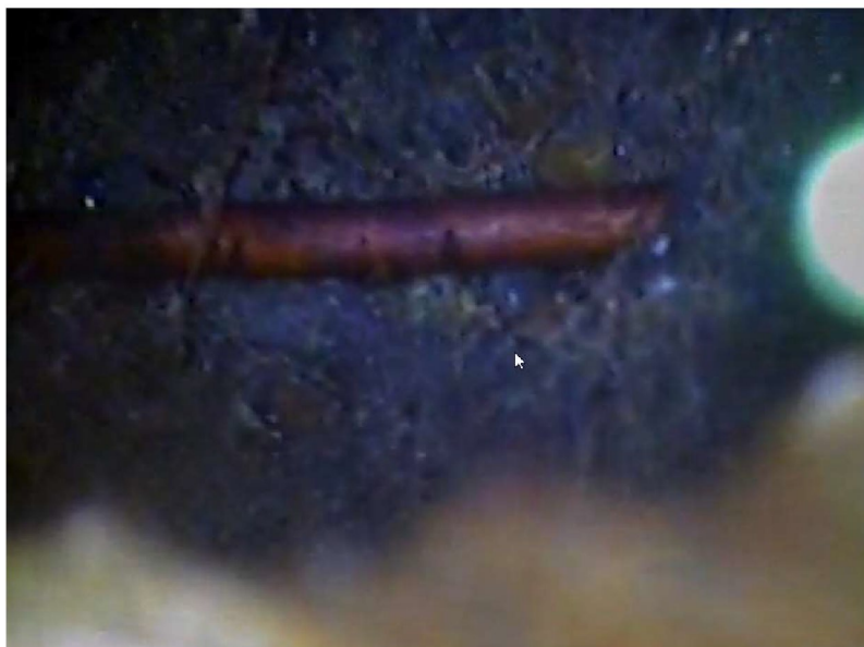
Bild 27. Foto murinspektion med inspektionskamera. Här ses rötter.
