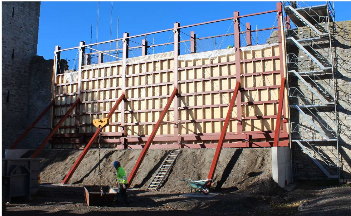
Bild 39. Exempel på temporär stödkonstruktion. (Visby ringmur. Foto Carl Thelin)
