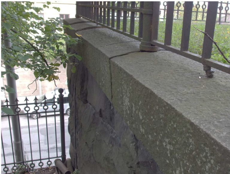
Bild 32. Vy av stödmur inifrån fastigheten. Litt. 6.
