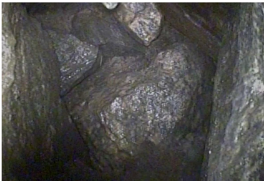
Bild 16. Foto från murinspektion med inspektionskamera.
