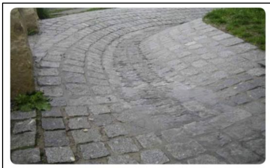
Figur 9-3. Ränna (Uppsala Vatten, 2016)
