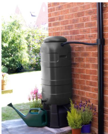
Figur 17, Dagvattentunna med anslutning till stuprörsledning, Greenline
