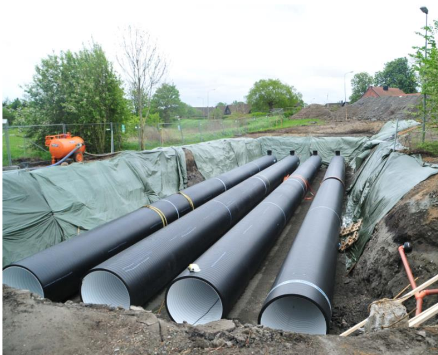
Figur 19. Rörmagasin i ledningsgrav
