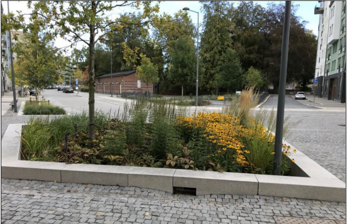
Figur 12. Exempel på nedsänkt regnbädd i Norra Djurgårdsstaden (Foto: Norconsult)
