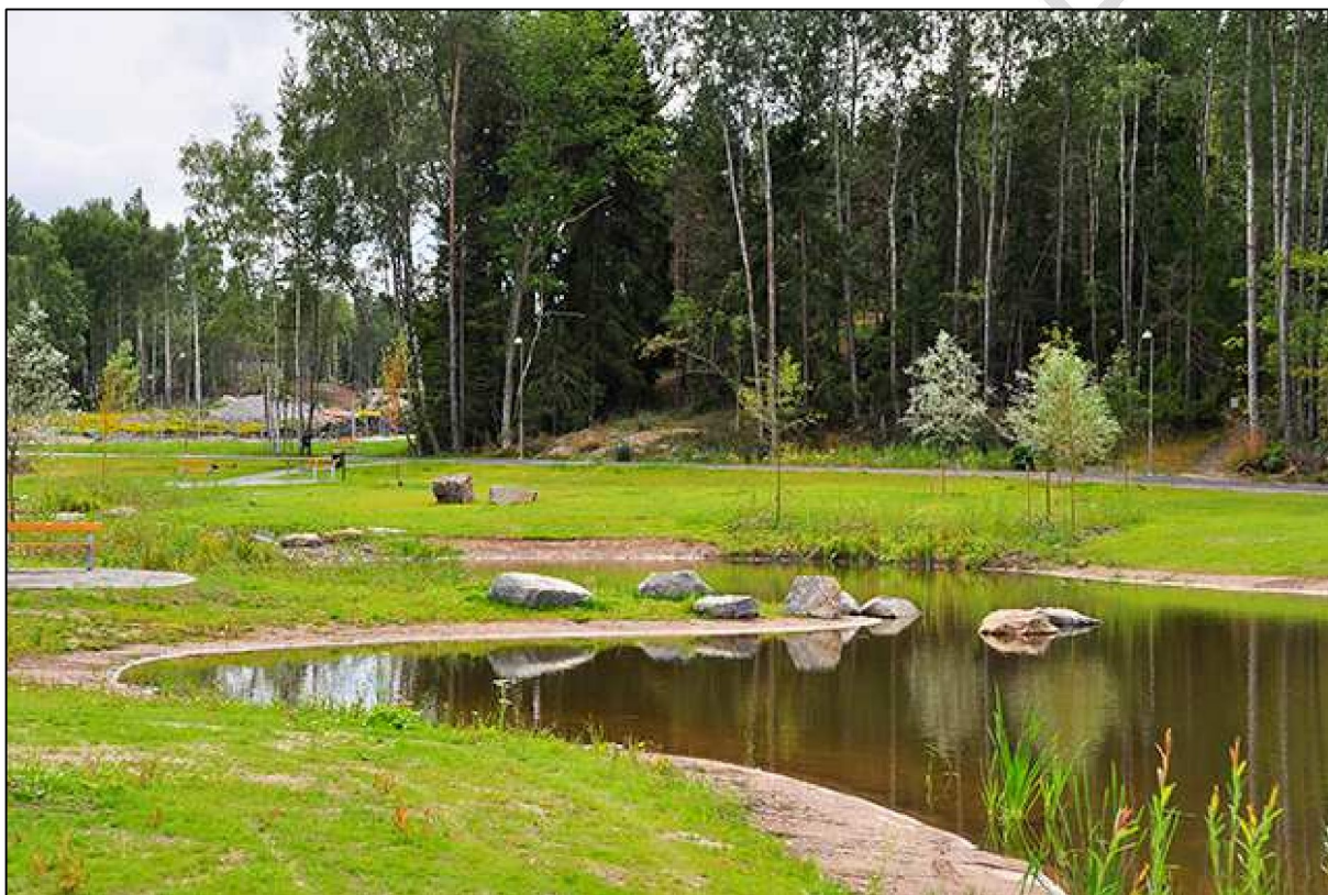
Figur 6-1. Exempel på dagvattendamm, här i Hedvigslund, Älta (Bildkälla: Novamark).
