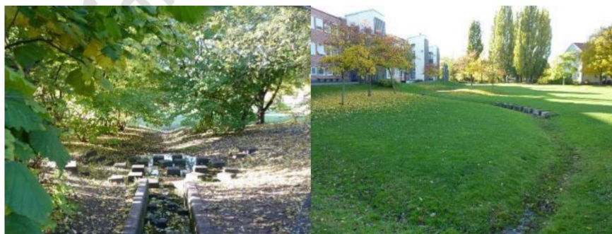
Figur 20. Exempel på utformning av en nedsänkt grönyta för infiltration. Foto: WRS.
