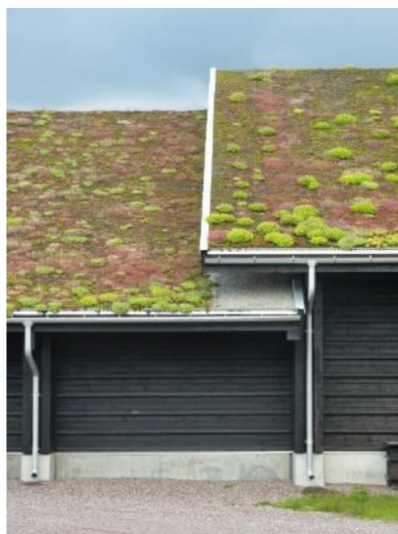
Figur 19. Exempel på ett extensivt sedumtak. Foto: WRS
