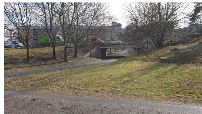
Figur 4. Foton från Östbergabackarna (Östberga Norra) överst, cykelpendelstråket längs Åbyvägen i mitten och GC-tunneln under Östbergabackarna längst ner. (Tyréns)
