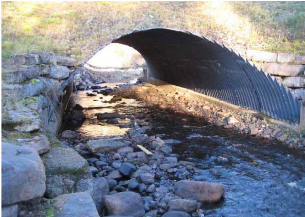
Figur 11. En bred och hög valvbåge skapar goda förutsättningar för groddjur att röra sig under vägen. Valvbågen som groddjursstråket löper genom ska vara minst 4-5 meter bred. Foto: Trafikverket.
