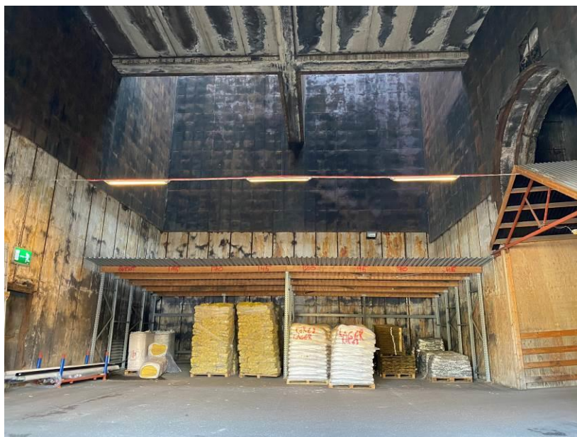
Den höga byggnaden från 1969 var utblåsningstornet, byggnaden är utformad som en gigantisk skorsten.
