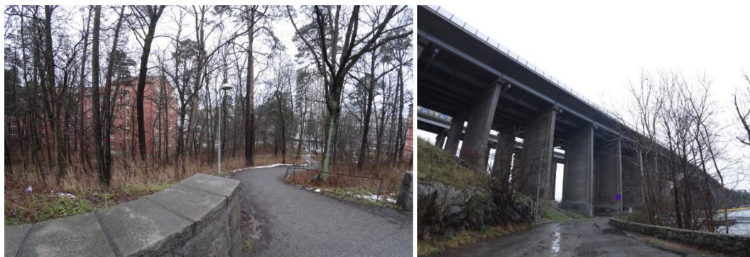
Bild 6. Anslutning till Tranebergsbron via brant gångbana genom skogen samt passagen under Tranebergsbron längst norrut på udden.
