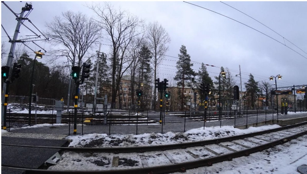
Bild 18. Saxad signalreglerad gångpassage vid Tvärbanestationen Alviks strand .
