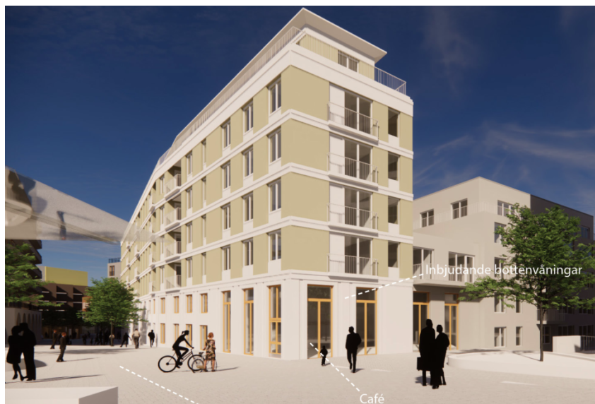
Vy mot kvarter B sett från stationstorget vid Alviks strands hållplats. (Brunnberg & Forshed)
