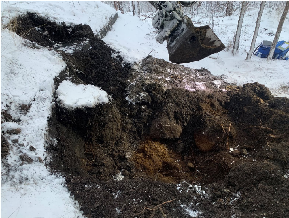
Figur 4-2 Fyllnadsmassor i punkt 1w42. I bilden syns fyllnadsmassor av sand grus och sten med mörka färger. I botten syns ett gyllenbrunt lager av sandig silt. Till vänster uppe i bilden syns värnets betongvägg och tak.
