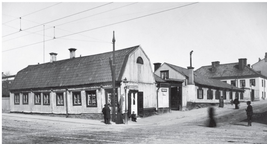
Fotografi Claes på Hörnet från 1904, korsningen Surbrunnsgatan - Roslagsgatan. Både mansardtak och sadeltak har förekommit vid fastigheten. I förgrunden ser vi nuvarande huvudbyggnad Hus A. Här ser vi även ett exempel på en portik för att markera entén till gården samt exempel på nätt gavelutsprång.
