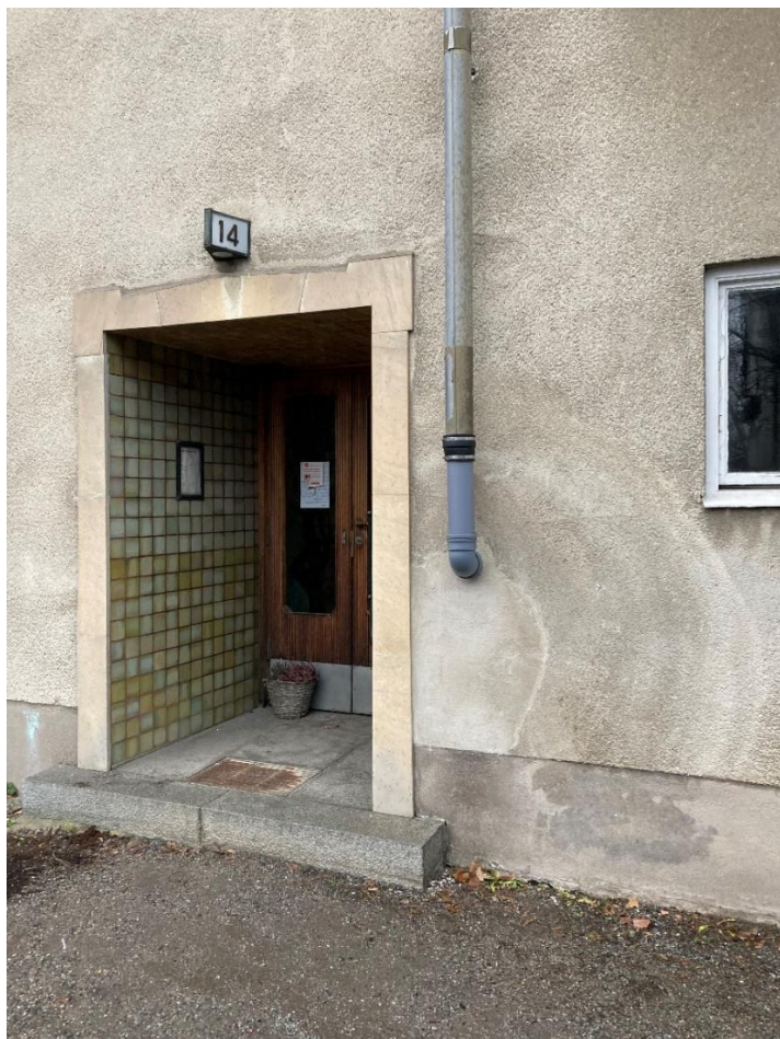
Figur 2-3. Stuprör som går in i byggnaden på sydöstra fasaden av den befintliga byggnaden.
