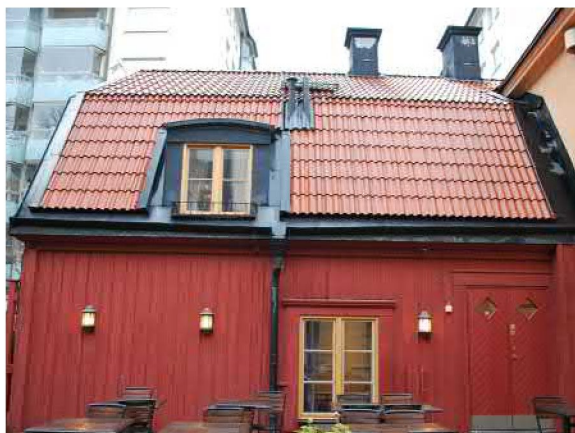
Fasad mot söder. Flygelbyggnaden är klädd i rödmålad locklistpanel. Taket har fotränna
