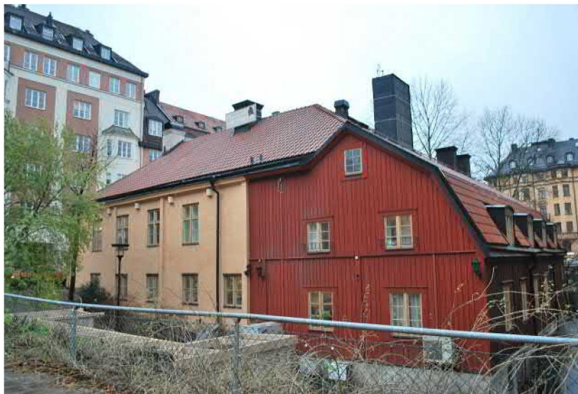
Fasad mot Birger Jarlsgatan. Flygeln har ett brutet tak med takfall mot norr som utgör en förlängning av huvudbyggnadens valmade sadeltak. Foto: nov-2019
