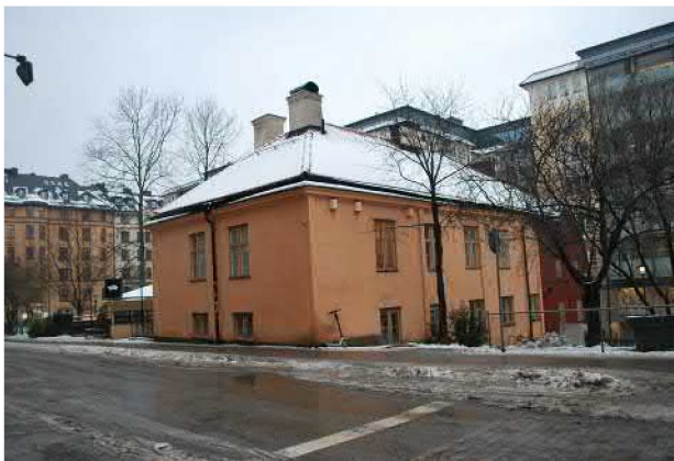
Huvudbyggnaden med gavel mot Surbrunnsgatan. Byggnaden är belägen i en sluttning mot norr.
