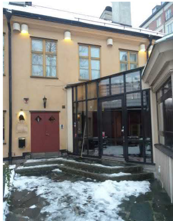
En inglasad länk till paviljongen har byggts in en del av fasaden mot gården i väster.
