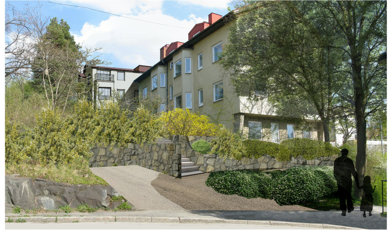
Bild efter ombyggnad, från Tvätterskevägen.
