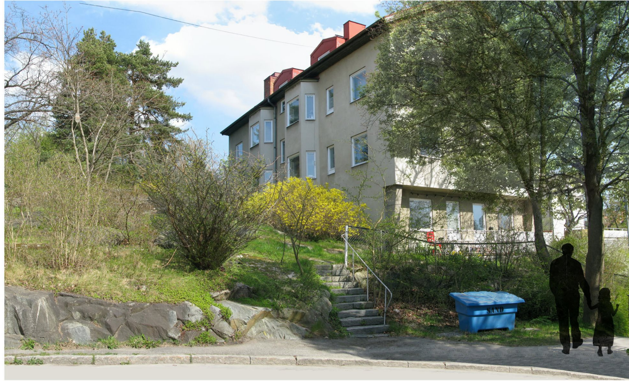
Bild före ombyggnad, från Tvätterskevägen.
