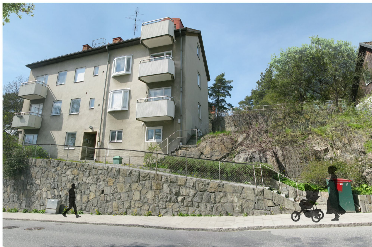
Bild före ombyggnad, mot entréfasad från Badstrandsvägen.
