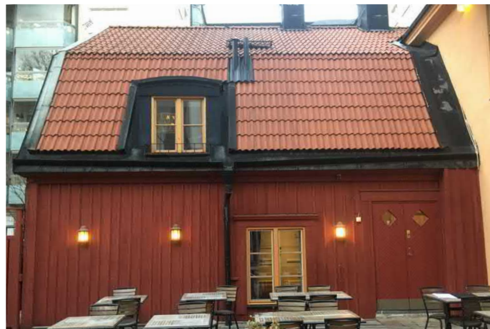
Flygelbyggnaden från 1980-talet är en tolkning av den tidigare timmerbyggnaden på platsen men med modern stomme och förlängd byggnadsvolym.
