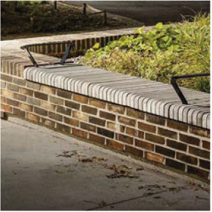
Murverk med bänk och grönska
