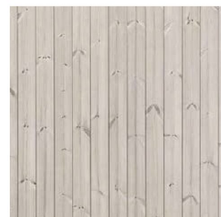
Trä i sockel och toppvåningar
