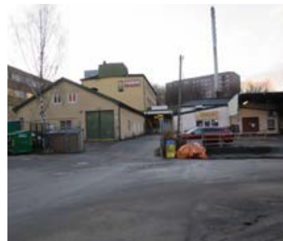
Figur 5 Befintliga verksamhetsbyggnader inom planområdet, Instrumentvägen sedd från öster.
