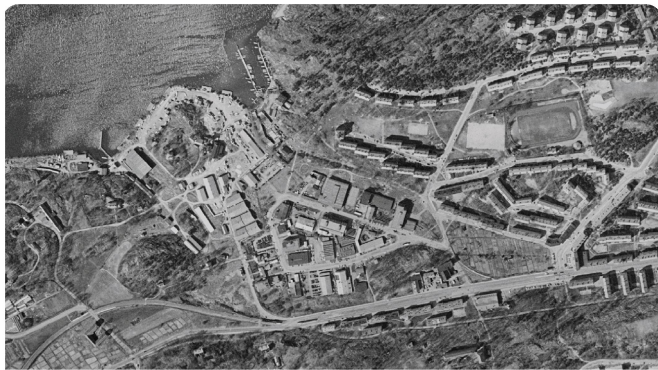
På ortofotot från cirka 1960 var tunnelbanan ännu ej anlagd och Örsbergsvägen har en något annorlunda sträckning mot Hägerstensvägen, invid korsningen syns bebyggelse som idag är riven. Merparten av kvarterens fastigheter var bebyggda när fotot togs. Lantmäteriet.
