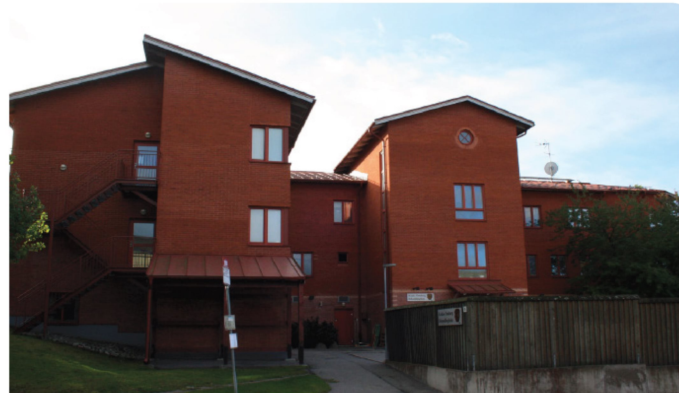
Provröret 16 (ingår ej i projektet). Mellan de två motställda byggnadsvolymer syns entréhuset. SWECO Architects
