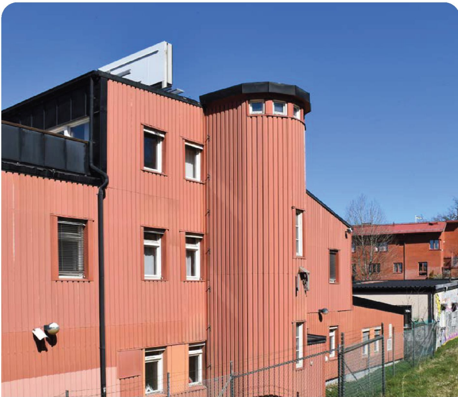
Byggnaden är kraftigt ombyggd i flera omgångar.
