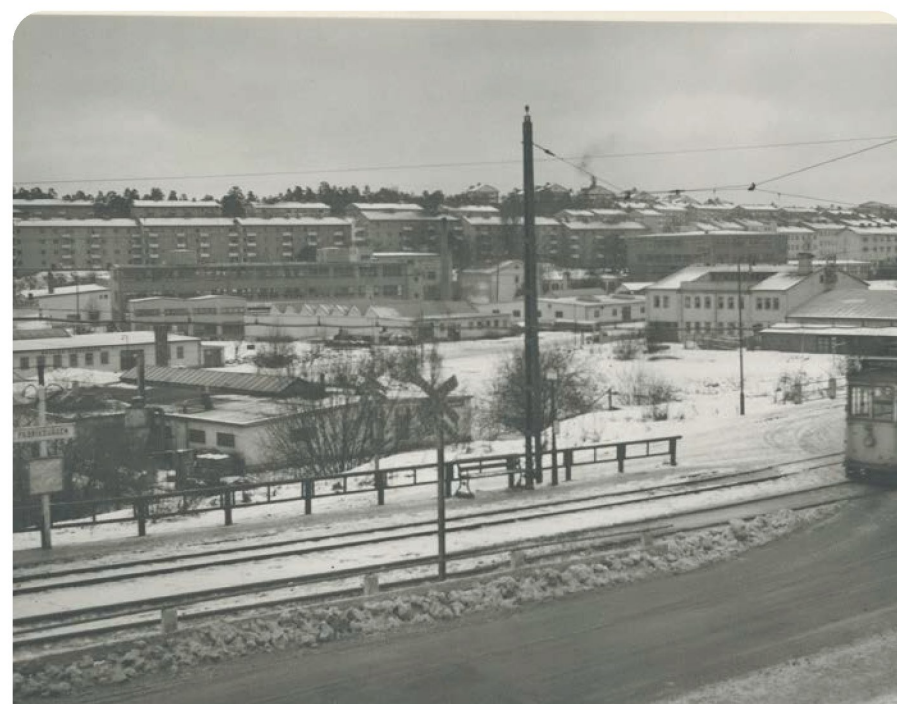
Utsikt från Fabriksvägens hållplats över industriområdet 1952. Märk sågtandade taket på Instrumentet 18. Digitala stadsmuseet.
