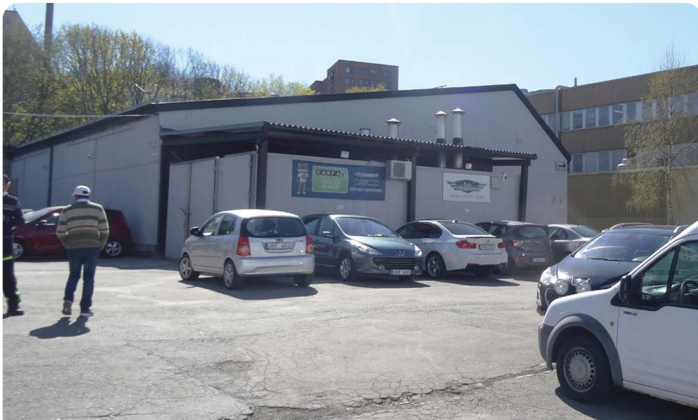
På fastigheten Provröret 14 finns två byggnader i plåt.
