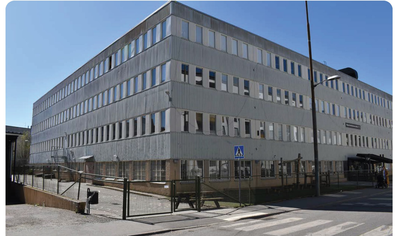
Byggnaden på Instrumentet 2 motsvarar en av områdets större byggnadskroppar.
