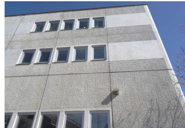
Instrumentet 13 - fasad i betong med varierande yta.
