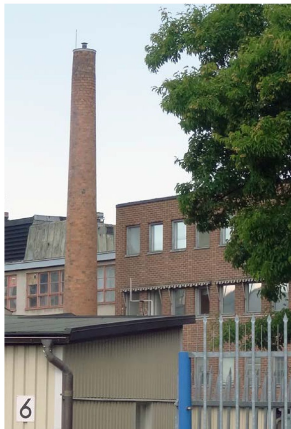
Skorstenen på fastigheten Instrumentet 17.
