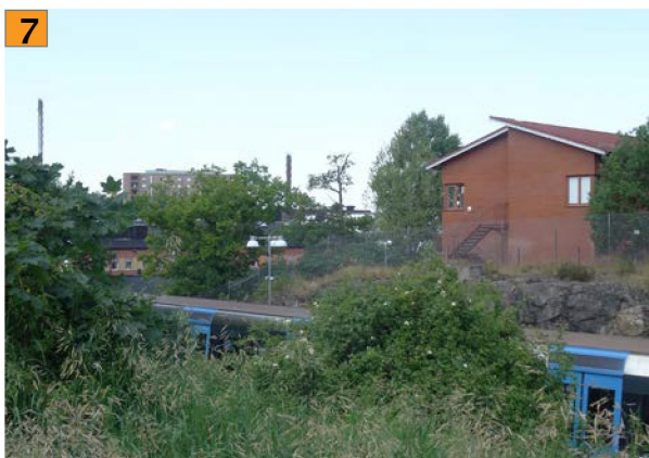
7 Från vantagepunkt söder om spåret uppfattas främst Provröret 16, den nyast uppförda byggnaden i området. Industriområdet ligger bakom lågt i topografien.
