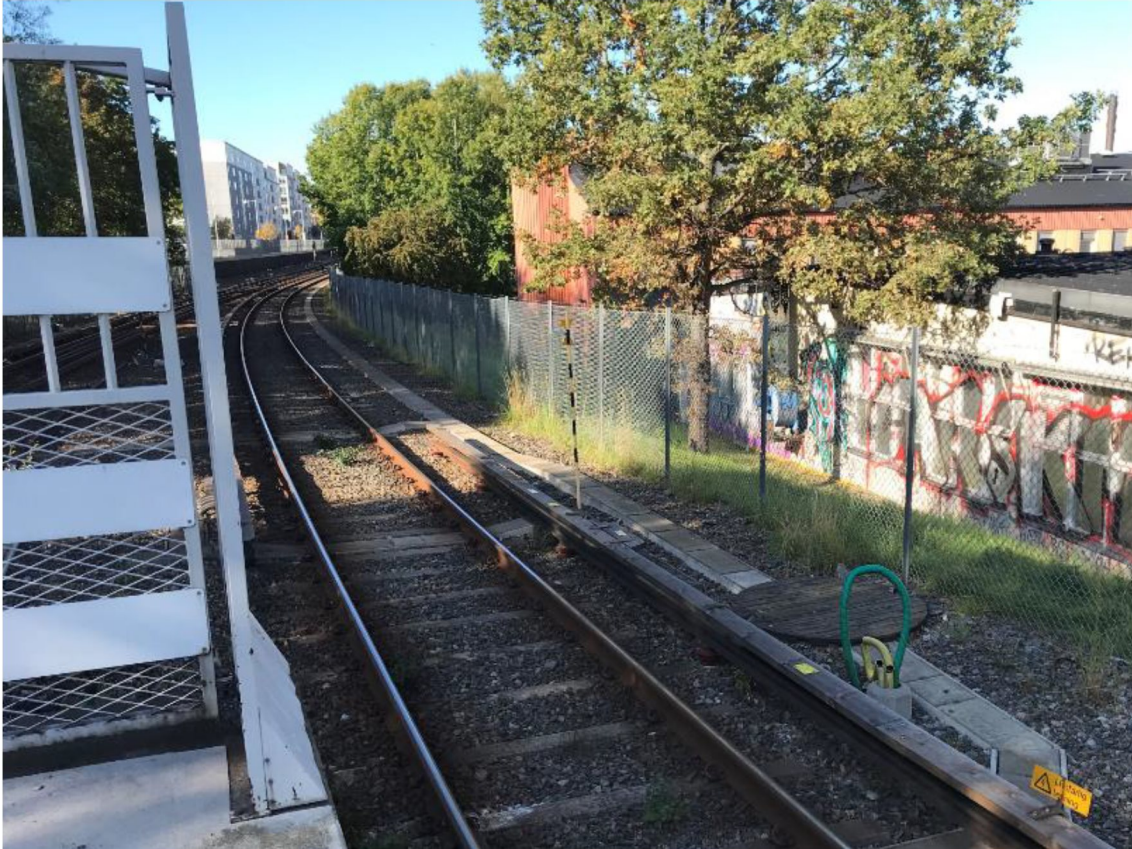
Figur 2. Foto taget från Örsnberg tunnelbanestation i riktning mot planområdet (till höger). Källa: Tyréns
