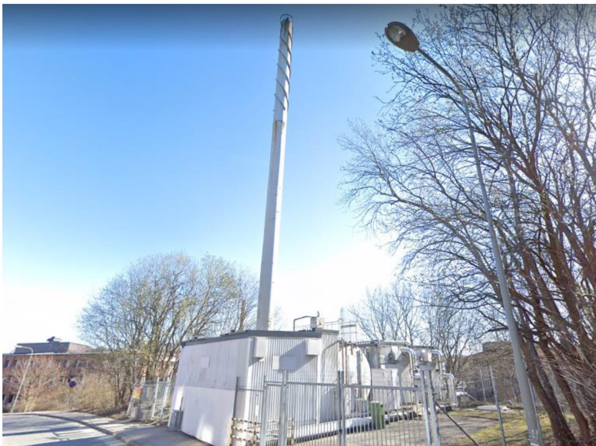
Figur 4. Stockholm exergis fjärrvärmeanläggning vid Selmedalsvägen.
