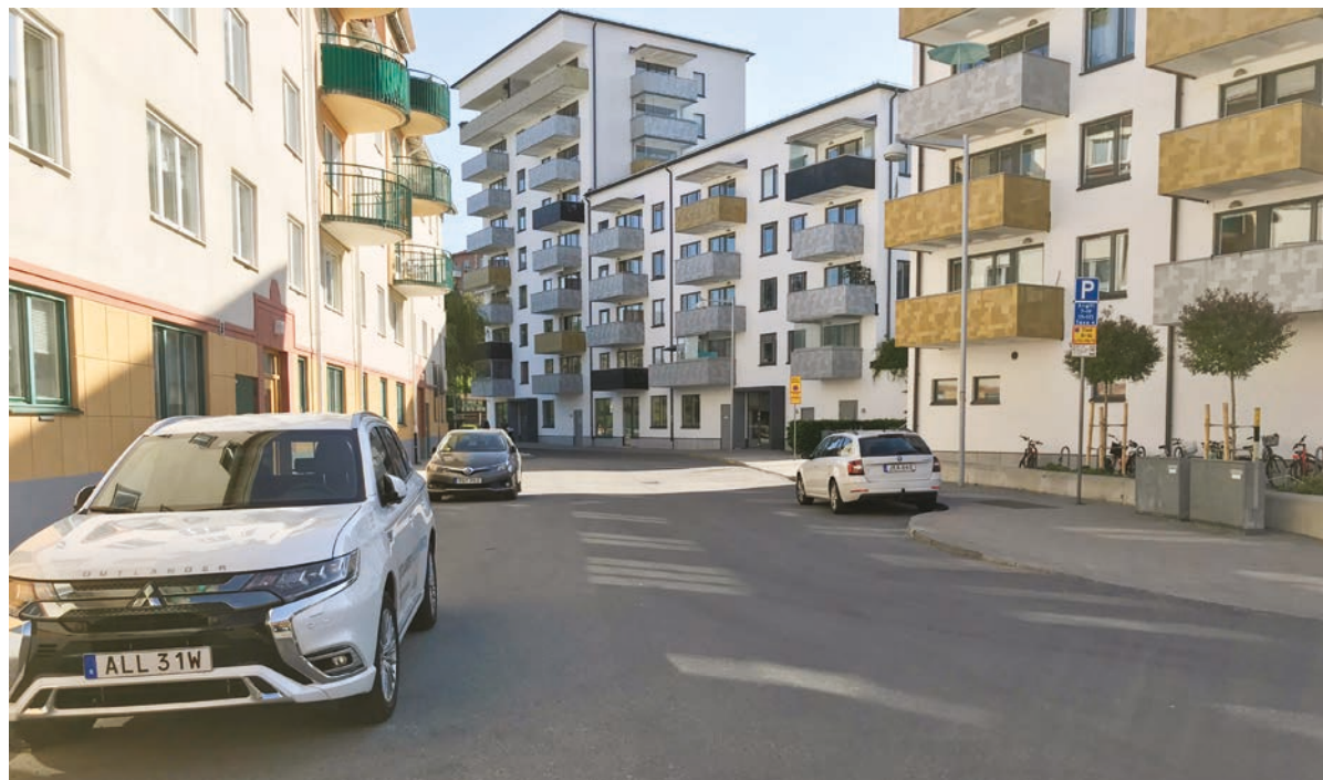
Figur 23. Vy mot norr på Instrumentvägen från korsning med Jakobsdalsvägen. Här är gatan plan med inbyggd lågpunkt som gör att skyfallsvatten bromsas upp på sin väg mot Mälaren.
