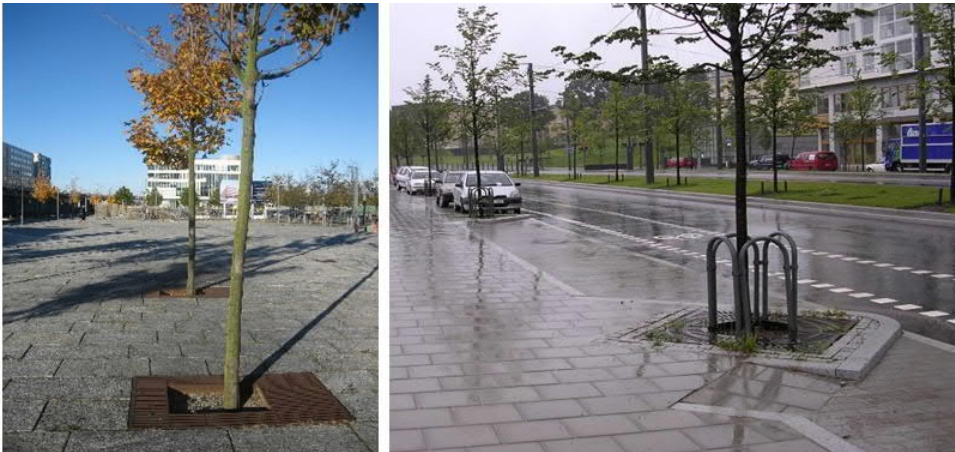
Figur 17. Exempel på trädplanteringar i skelettjordar vid torg och vid gata. Foto: Sweco
