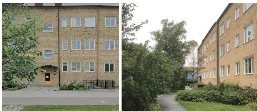
Befintlig bebyggelse inom fastigheten Jordärtskockan 9.
