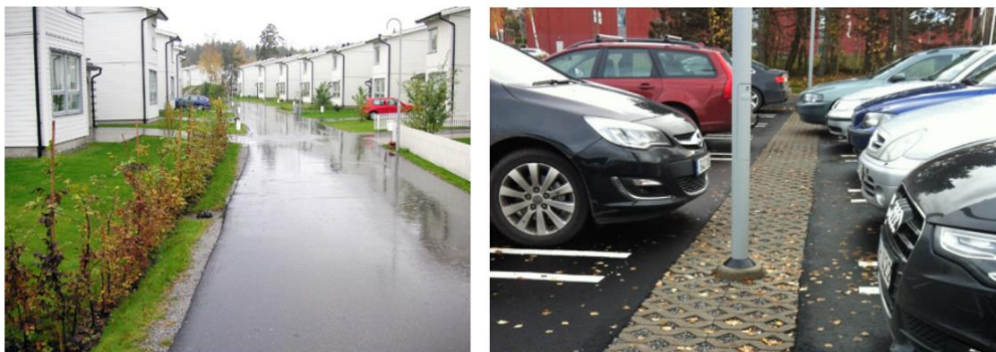
Figur 19. Två exempel på krossdiken/makadamdiken. T.v. makadamdike mellan lokalgata och tomtmark. T.h. makadamdike på parkeringsplats där ett raser av betong har lagts i överytan. Foto WRS (Stockholm Vatten och Avfall, 2017a).
