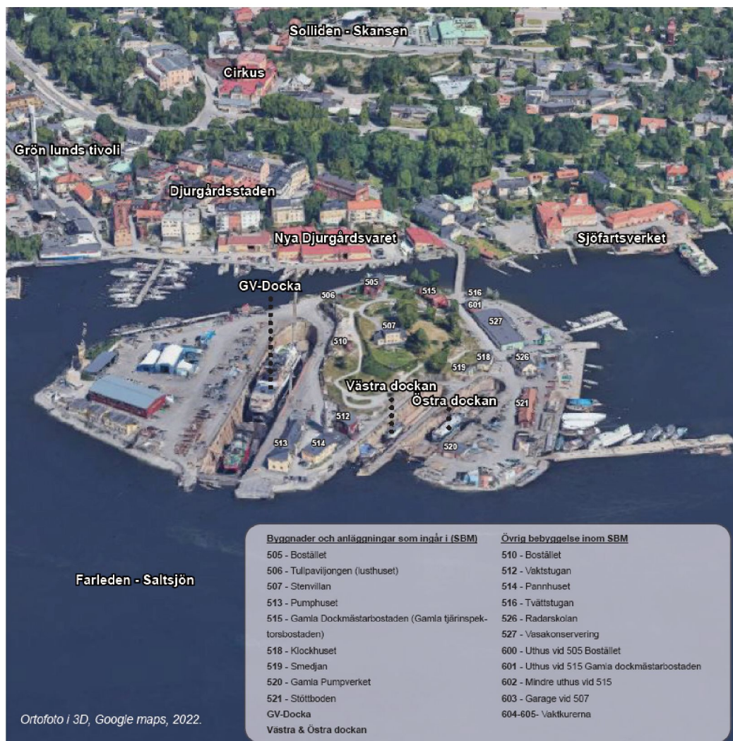
Ortofoto med det statliga byggnadsminnet Beckholmen. Källa: Sweco
