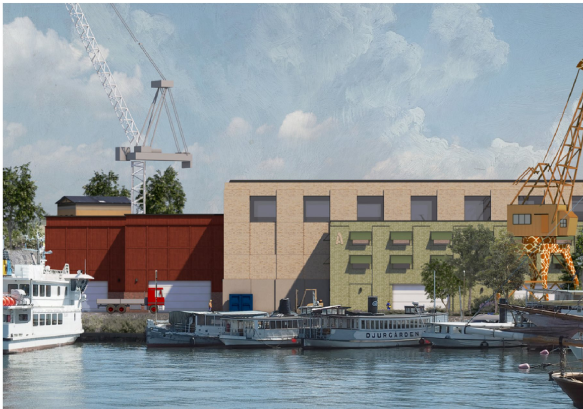
Vy mot öster med de nya verkstadsbyggnaderna, giraffkranen bevaras som ett industriminne på Beckholmen.
