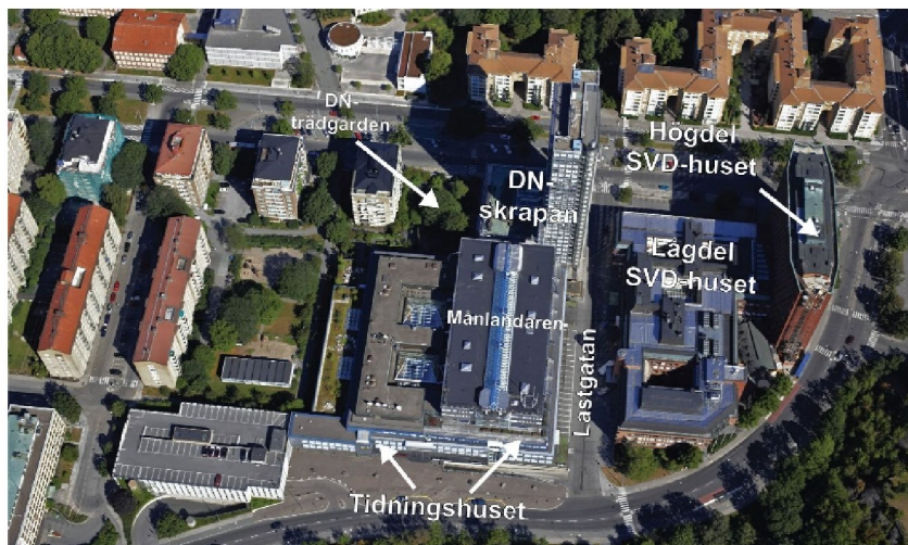
Befintlig bebyggelse inom Trängskåren 6 och 7.
