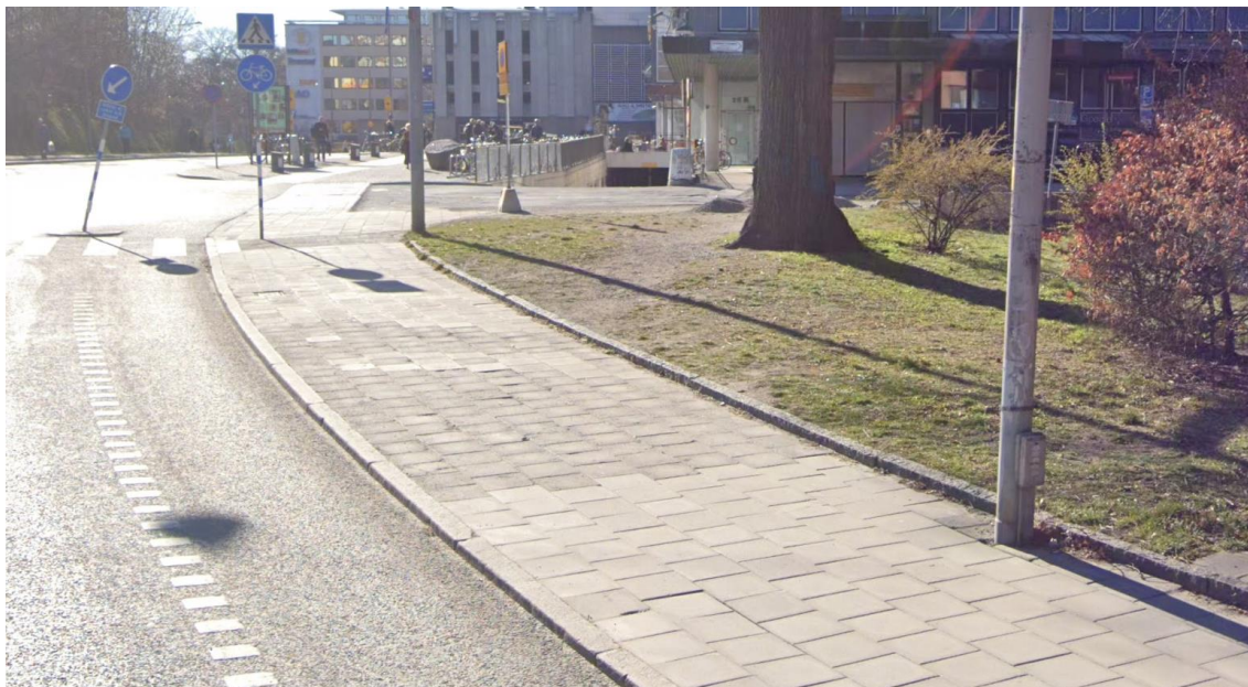
Figur 4: Gångbanan längs norra sidan av Görwellsgatan, framför TK 6.
