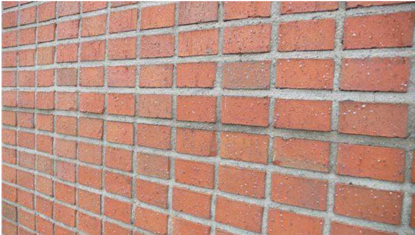
Höghusets gavlar är även de murade i enbart löpskift, medan långfasaderna murats i enbart koppskift.
