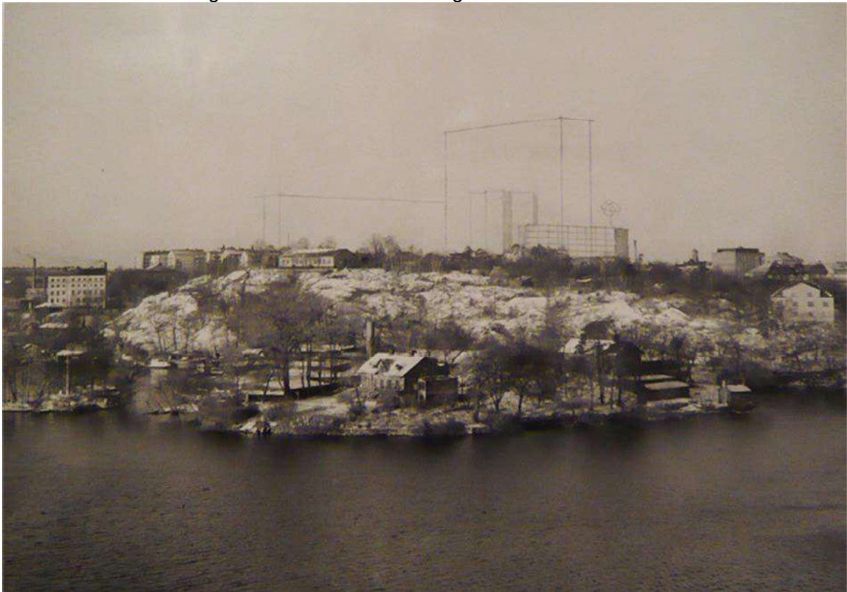
Mariebergssområdet sett från Västerbron med dagbladshuset, DN-huset m.fl byggnader inritade. Källa: Tengboms arkiv.
