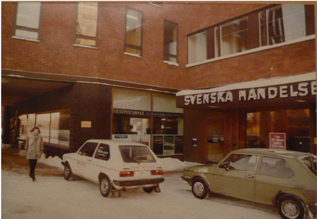
Den öppna pelargången sedd från nordväst. Källa: Tengboms arkiv.
