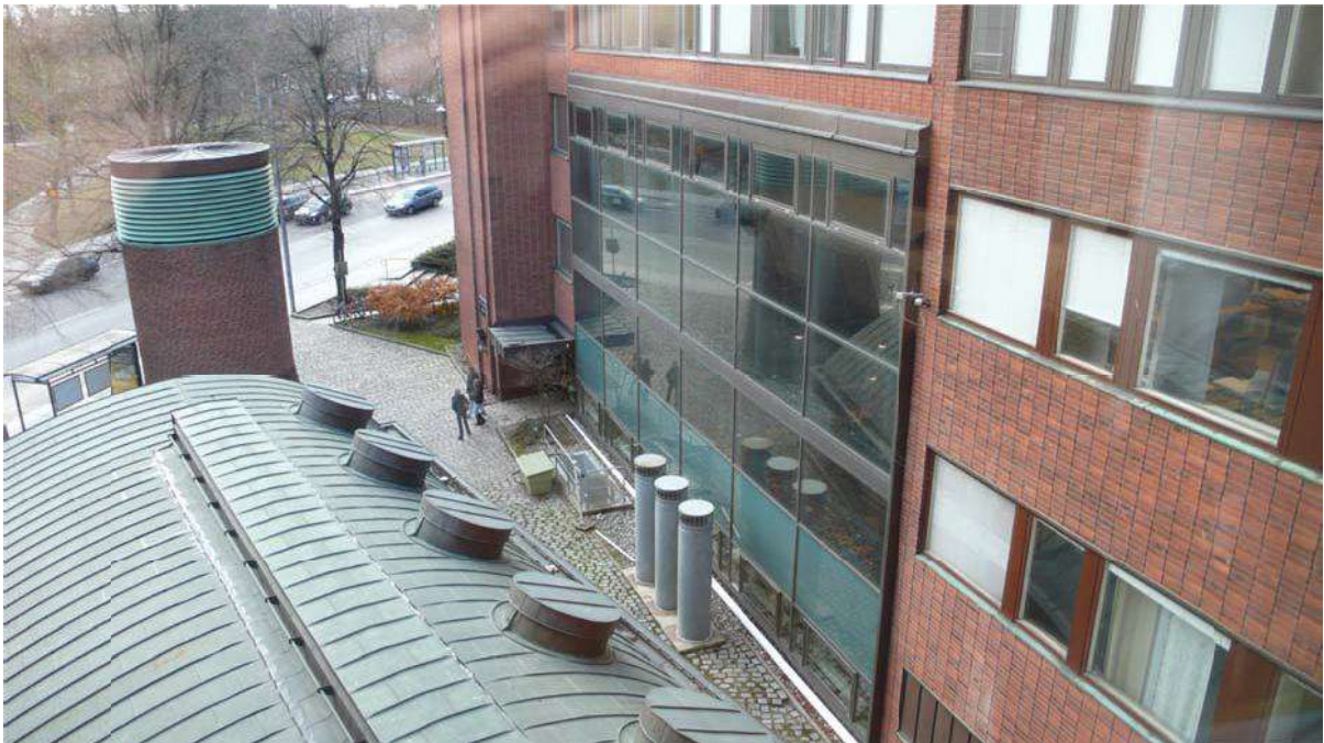
Tryckpressarna stod i en tryckerihall i lågdelens sydöstra hörn. Hallens höga rumshöjd, viljan att ta in dagsljus i hallen och viljan att exponera tryckeriprocessen mot omvärlden gjordes synlig i fasadarkitekturen genom ett högt och brett glasparti.
