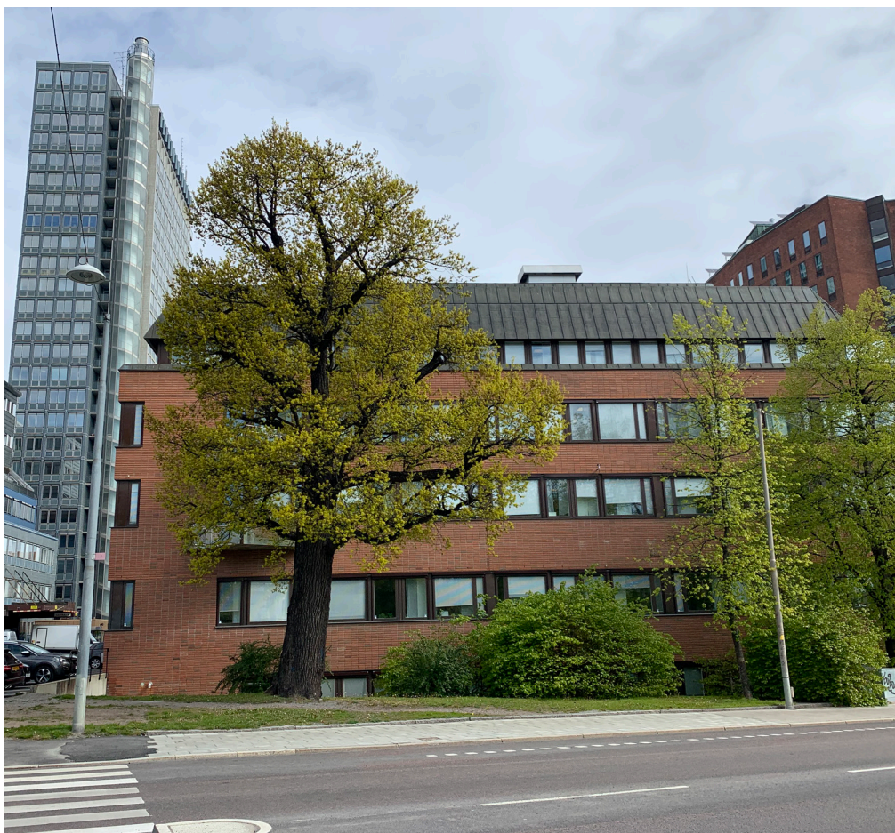
Trängkåren 6 med tillbyggnaden mot söder från 1991 som saknar rumslig och social relation till gatan. Utformningen ger ett intryck av att platsen är en baksida i kvarteret.
