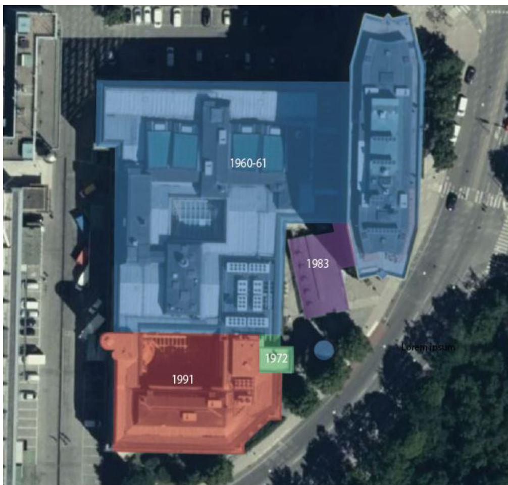
Färgmarkering av de olika huskropparnas byggnadsår
