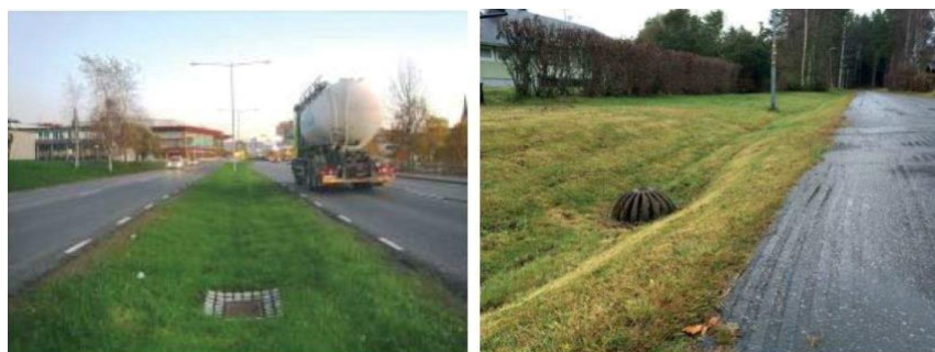
Figur 22. Två exempel på svackdiken. (Svenskt Vatten Utveckling, 2019)
