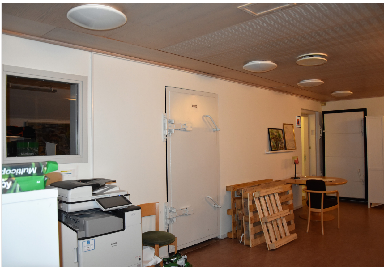
Figur 127. Här ses dörrarna in till skyddsrummet på nedre plan i den östra delen av byggnaden. Det märkliga är att skyddsrummet som används som förråd har ett fönster ut mot korridoren.
