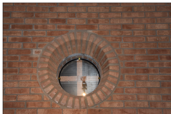
Figur 25. Oxöga/ runt fönster ovan kyrksalens glasade entrédörrar.
