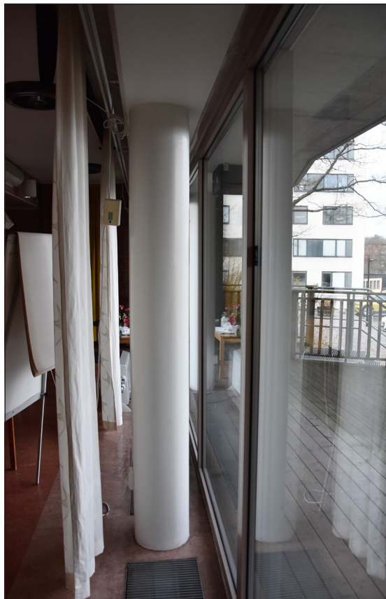
Figur 112. Pelare invid fönstret i allrummet.
