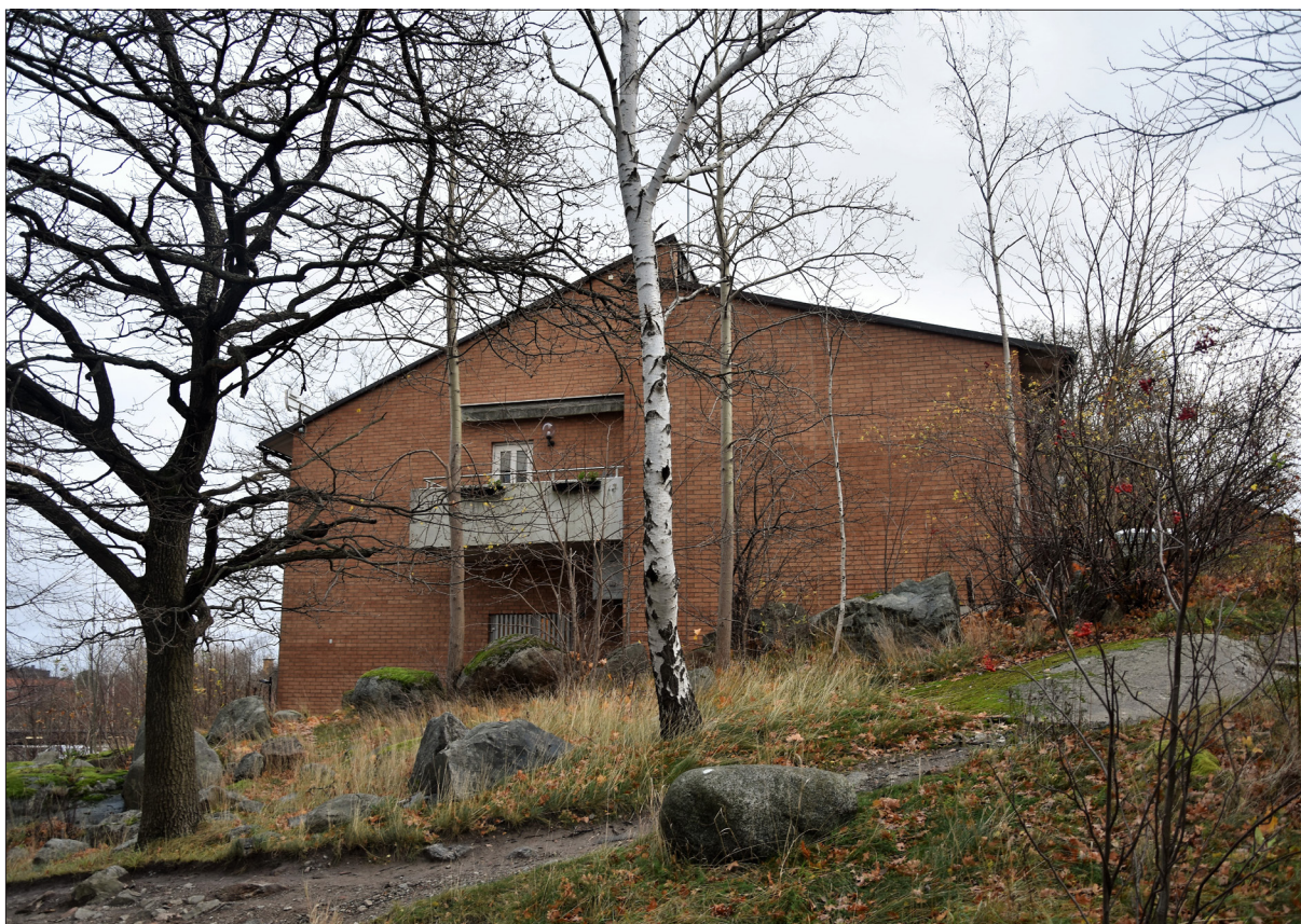
Figur 19. Västra gaveln är försedd med balkong i formgjuten betong.
