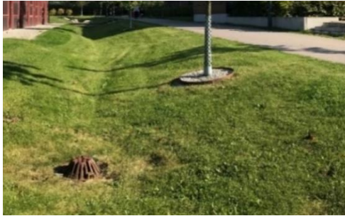
Figur 6-3 Exempel och principskiss på infiltrationsdike. Foto Structor Uppsala AB samt greenworkspc.com (2018-01-18). Principskiss av WRS (2017).
