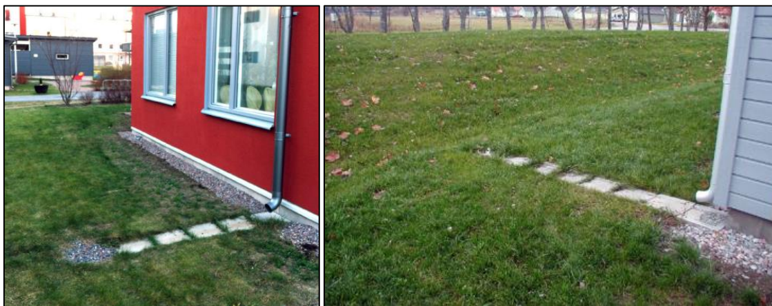
Figur 9-2. Två alternativ för att avleda takvatten till en grönyta för infiltration. Till vänster leds vattnet till en liten stenkista i grönytan och till höger till en skålad grönyta (Stockholm Vatten och Avfall, 2022a).
