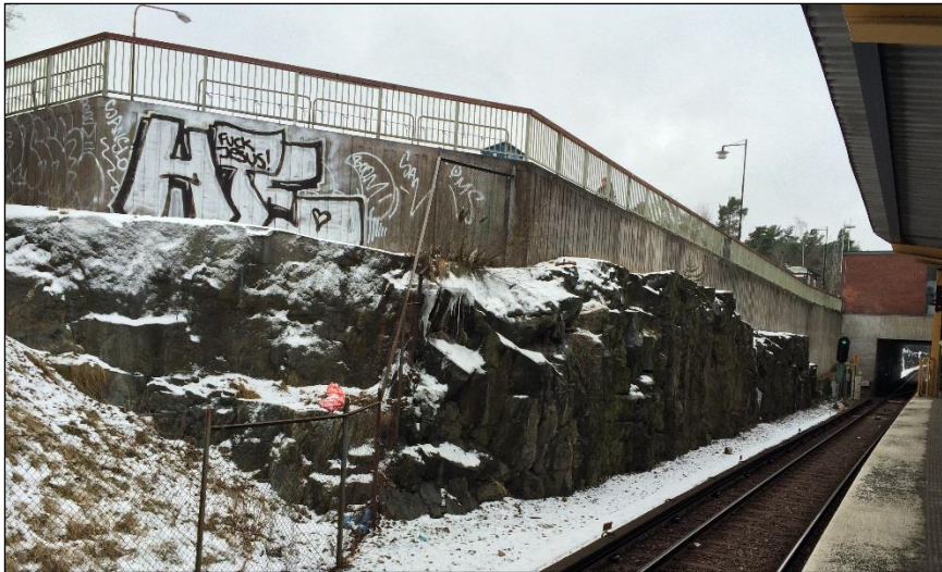
Figur 7 Bergslänt söder om tunnelbanespår (vy mot väst).
