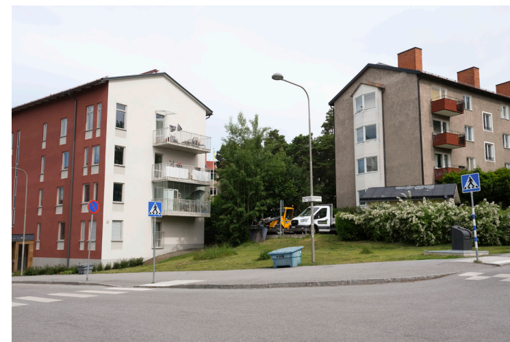
Möte mellan 1950-talets smalhus till höger och ett sentida utfört förtättningsprojekt till vänster. Notera skillnaden i våningsantal, tjocklek på byggnaderna, detaljeringsgrad, balkongstorlek och markbehandling i direkt anslutning till byggnaderna.
