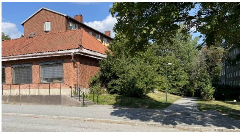
Befintlig byggnad på Farfarstjärnan 2 till vänster och parkstråket till höger.
