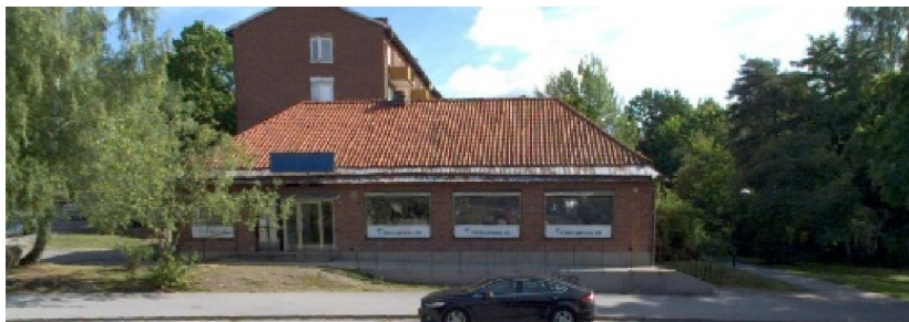
Befintlig byggnad. Fasad mot Bäckaskiftsvägen.
