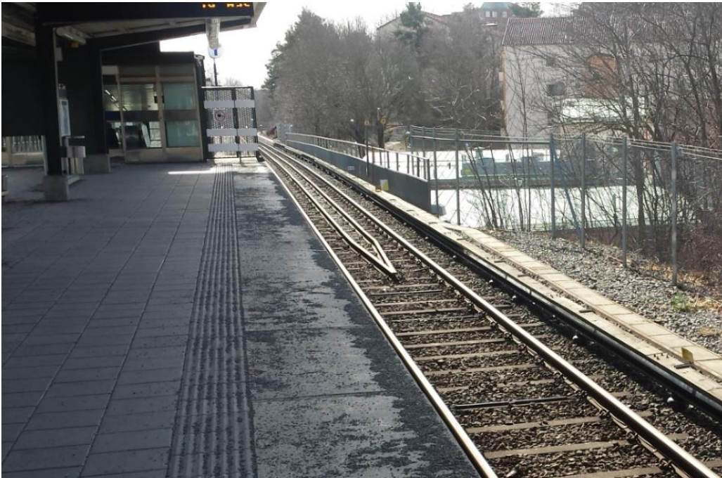
Figur 5. Foto taget i sydlig riktning där urspårningsrälens placering framgår. Källa: Briab.
