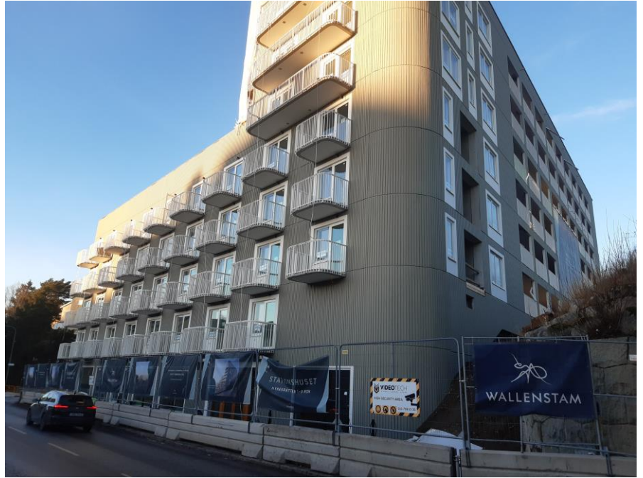
Murförbandet 1 från Trollesundsvägen
