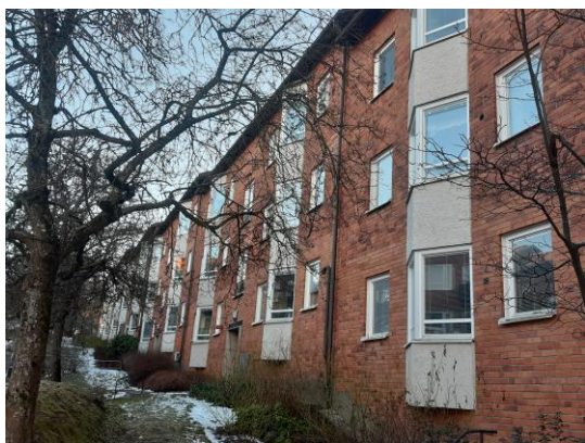
Gulskivan 1, vid Björksundsslingan 1950-talet, Flacka utvinklade burspråk som inspirerat till planförslagets vertikala markeringar på loftgångsfasaden.
